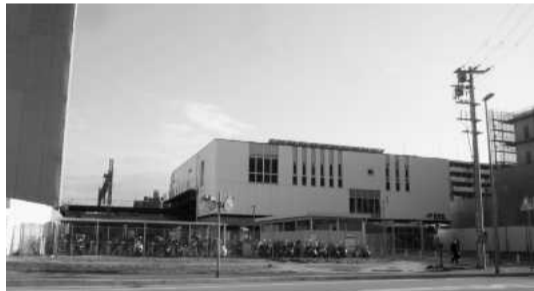
JR摩耶駅周辺は新しいマンションや大型店舗などが今も建設中
