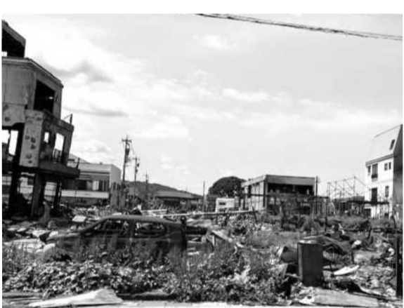
輪島市の朝市エリアは震災直後とほとんど変わらない風景が残ったまま＝輪島市
